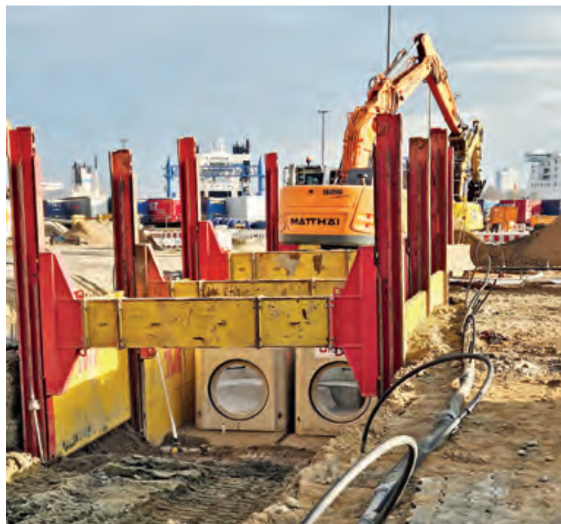
Einbau Doppelstrang-Kanäle DN 1000 mit TWF-Gleitschienenverbau.
