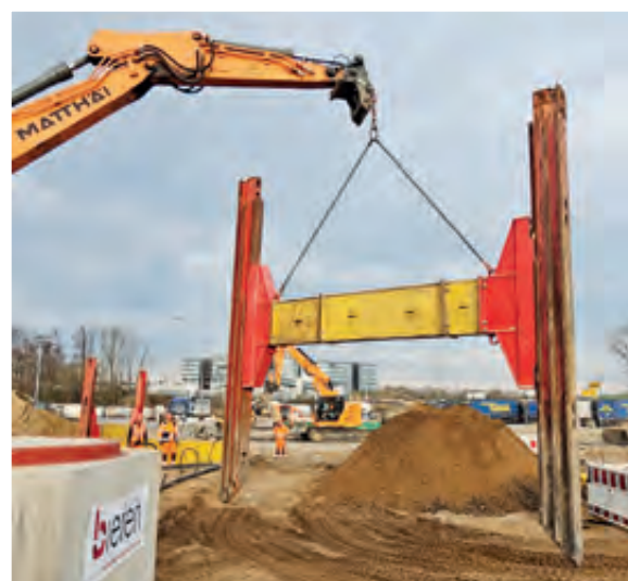
Platzieren des flexiblen TWF-Gleitschienenverbau: Die persönliche Einweisung durch TWF-Berater vermeidet Fehler beim Einbau.
