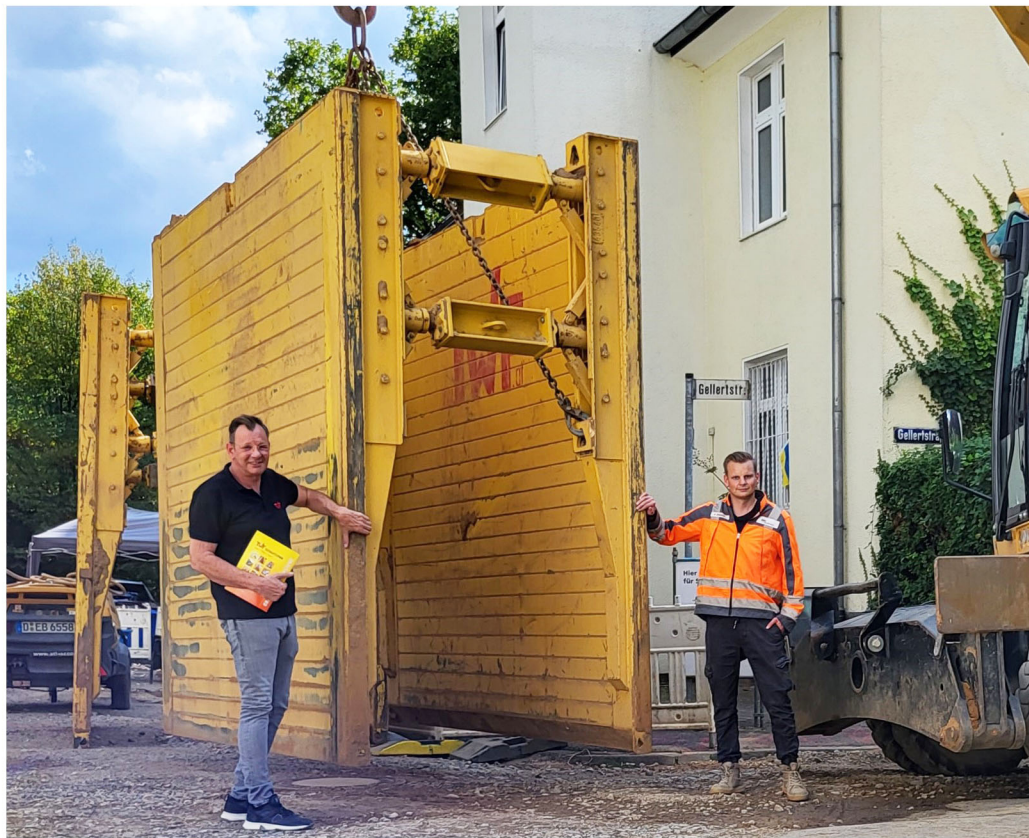
TWF-Fachberater Christian Becker (l.) und EBG-Projektleiter Pascal Znidarec auf der Leverkusener Baustelle vor einer der XL-Verbauboxen. FOTO: TWF TIEFBAUTECHNIK
