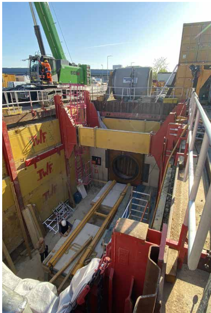
Die Pressgrube für den Vortrieb DN 2200 mit TWF Gleitschienenverbau.
