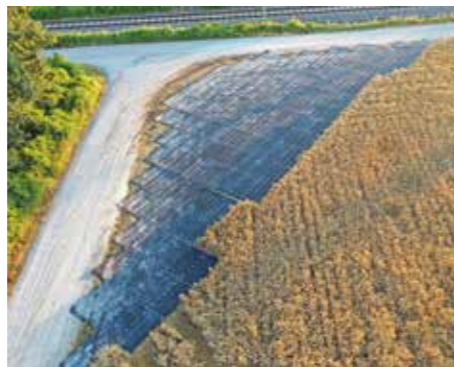
Nach dem Rückbau der MRS Medium Bodenschutzplatten präsentieren sich die Flächen ohne Schäden.
