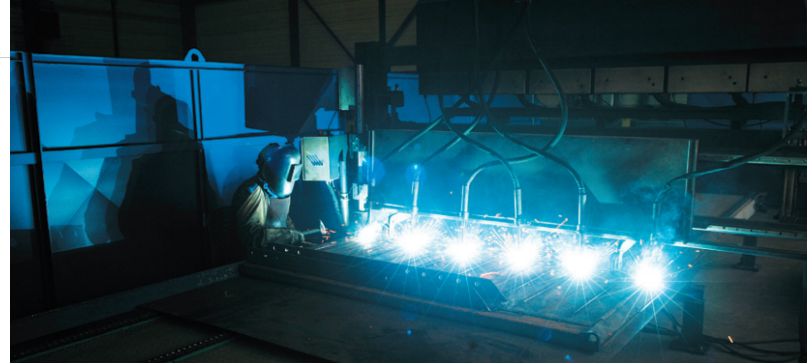
Hochleistungsschweißautomat in der Grabenverbauproduktion
