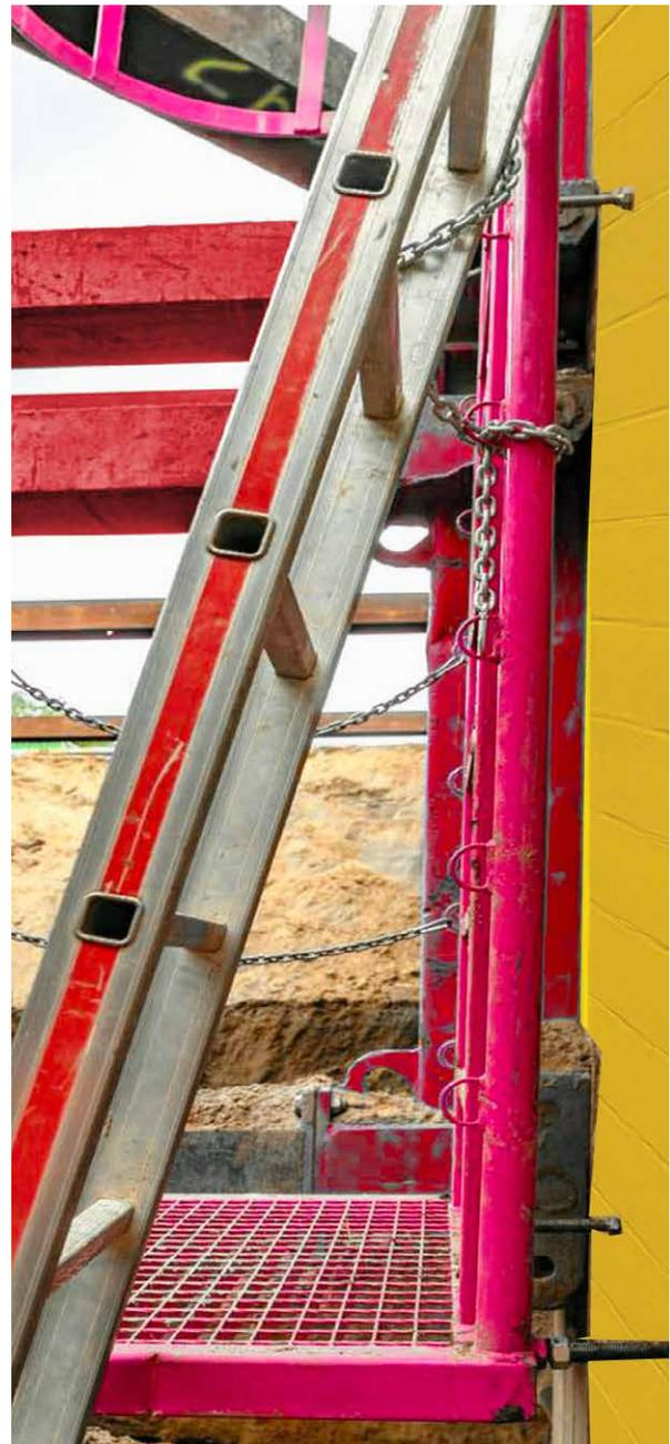
Je nach Anlegeposition stehen beidseitig 5 Ösen zur Befestigung des Karabiners an der Kette zur Verfügung.
