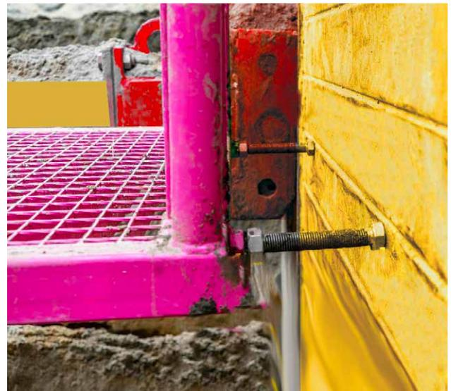
Am unteren Podest und an möglichst jedem zweiten Zwischenstück der Verbauleiter befinden sich 2 Einstellschrauben (SW30) zur lotrechten Ausrichtung. Der Mindestabstand zum Verbau muss 150 mm betragen um für ausreichende Trittsicherheit zu sorgen.
