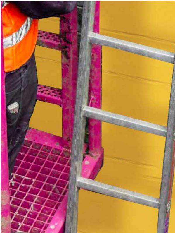
Das letzte Stück des Abstiegs in die Baugrube wird durch eine Anlegeleiter realisiert. Diese kann beidseitig am unteren Podest der Verbauleiter angebracht werden.
