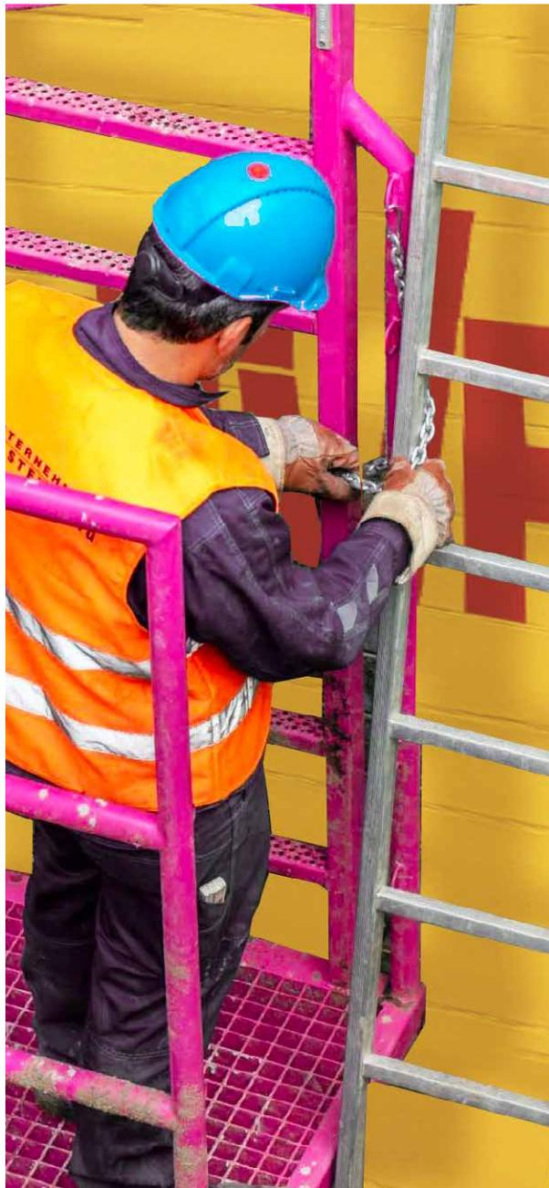
Die Leiter wird an der Anlegeseite mittels einer Kette so stramm wie möglich um den Leiterholm fixiert um ein seitliches Kippen zu verhindern.
