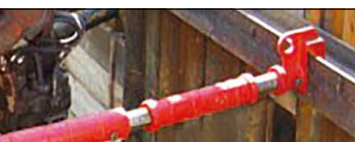
Solución especial: Codal con cabezal RDH para vigas HEB
